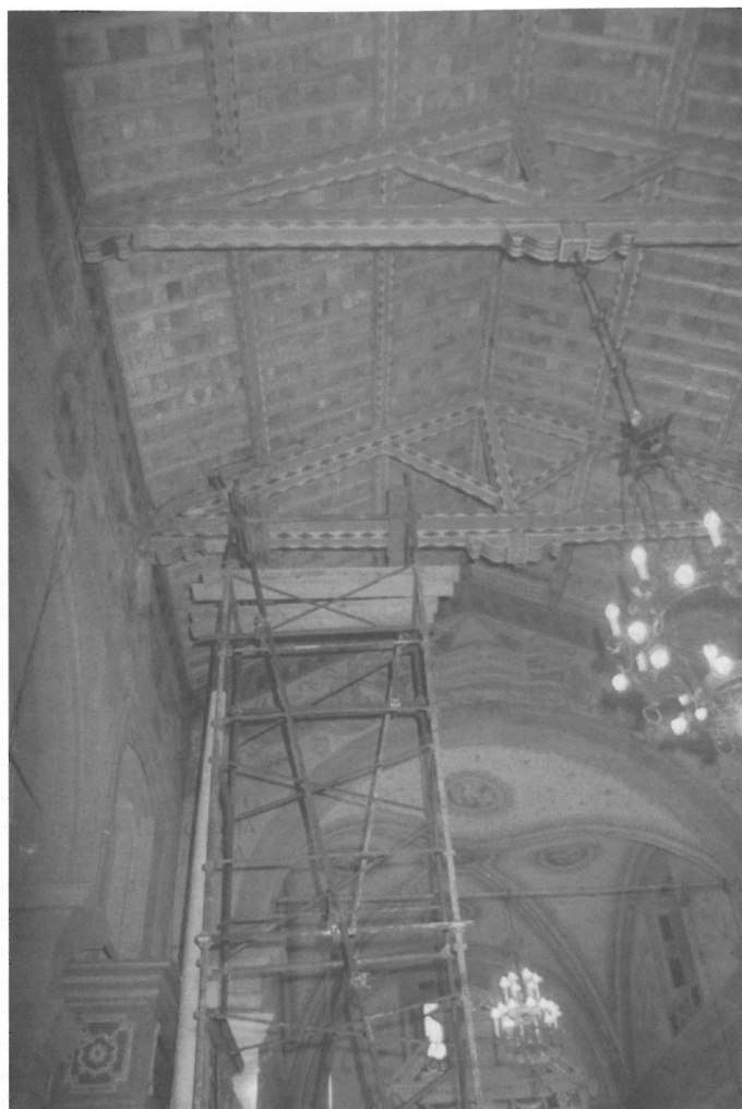
FOTO 2 Capriata pericolante: il carico si era trasferito al palo di legno, che, per la sua «snellezza» era sbandato appoggiandosi al pulpito.
