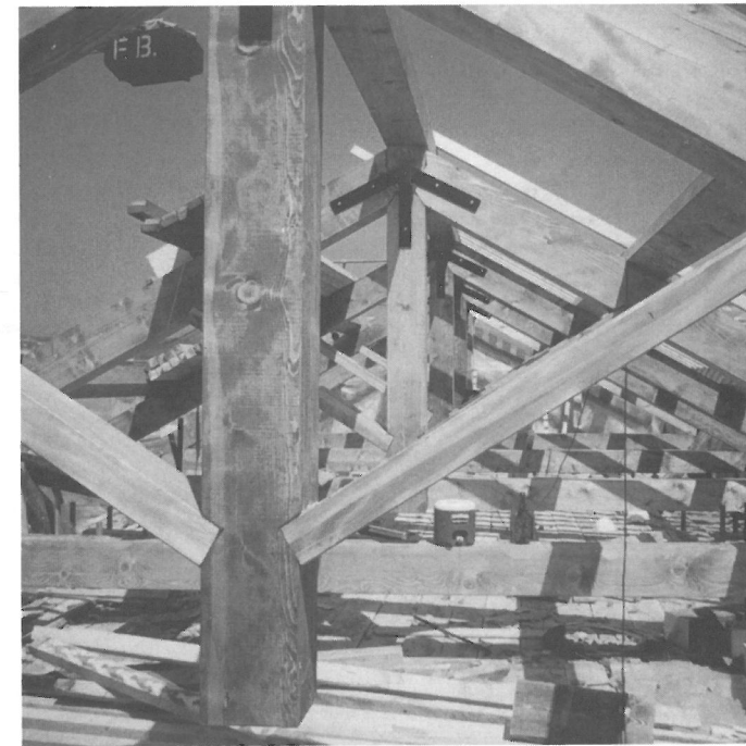
FOTO 5 Le nuove strutture del coperto durante il montaggio.
