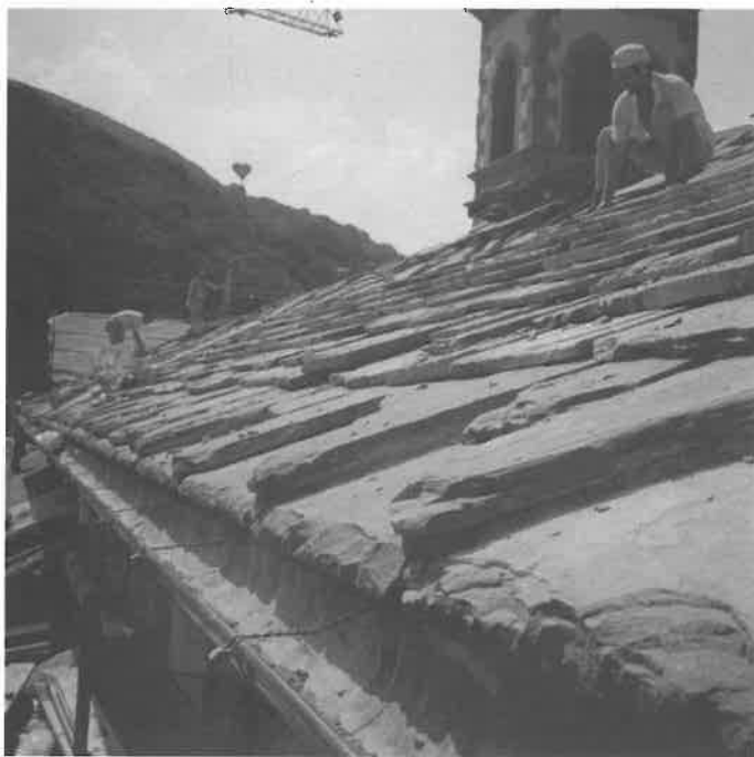
FOTO 6 Posa del nuovo manto di copertura in lastre di arenaria a «spacco».
